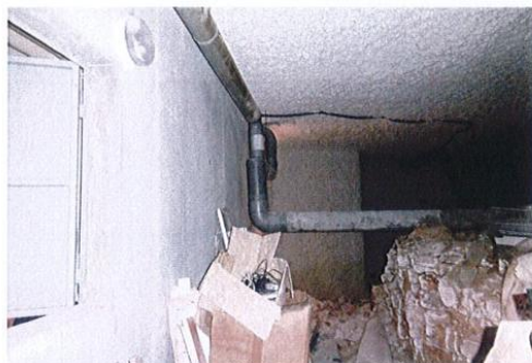
Composant : Conduit de fluide (eau) 4 (N) canalisation PVC vide sanitaire - réseau d'évacuation
